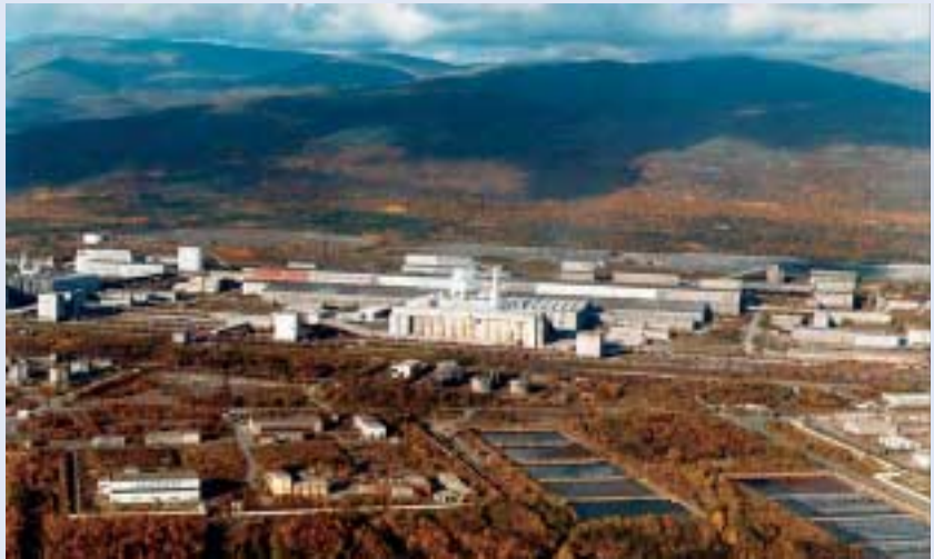
Апатит-нефелиновая фабрика №2 у подножья Хибин The apatite-nepheline processing plant at the Khibiny Mountain
