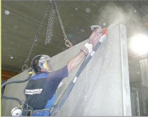
Kuva 3. Seinäelementin viimeistely käsihiomakoneella, johon on kytketty pölynpoistimuri.
