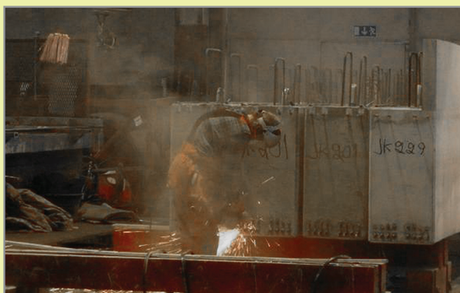
Kuva 2. Jännepunoksen viimeistelykatkaisu kulmahiomakoneella. Työntekijän tulee käyttää moottoroitua tai paineilmaverkkoon liitettyä hengityksensuojainta.
