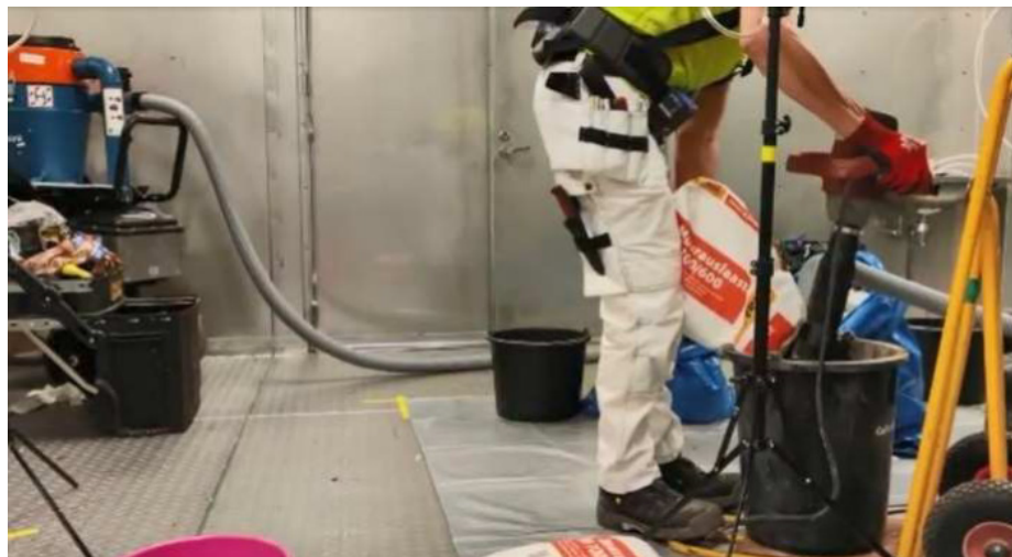
KUVA 2. Sekoittajiin suunniteltu laitekohtainen kohdepoisto (huuva).
