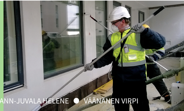
Bild: Skyddsbehandling av vägg med nanopreparat
