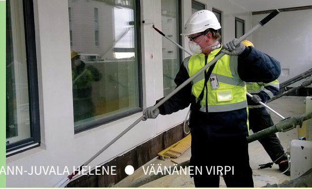
Kuva: Seinän suojakäsittelyä nanovalmisteella
